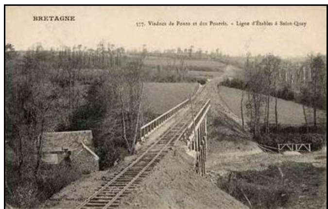
Ci-dessus et ci-dessous, toujours signé Harel de la Noë, le viaduc des Pourris 92 m de long, 17 de haut, comportant 10 arches plein cintre
