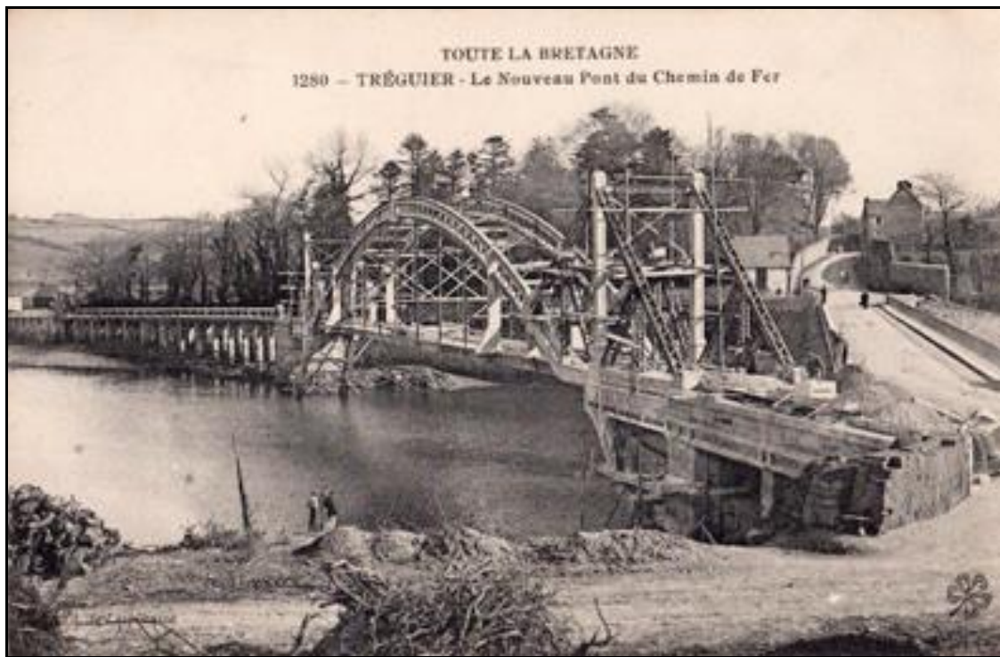
Le Pont Noir ferroviaire vu à contresens de la ligne, pendant sa construction avec, à sa droite, le pont routier dont la chaussée traversait la voie ferrée par un passage à niveau Noter, côté Tréguier, la longue passerelle d'accès au tablier principal
