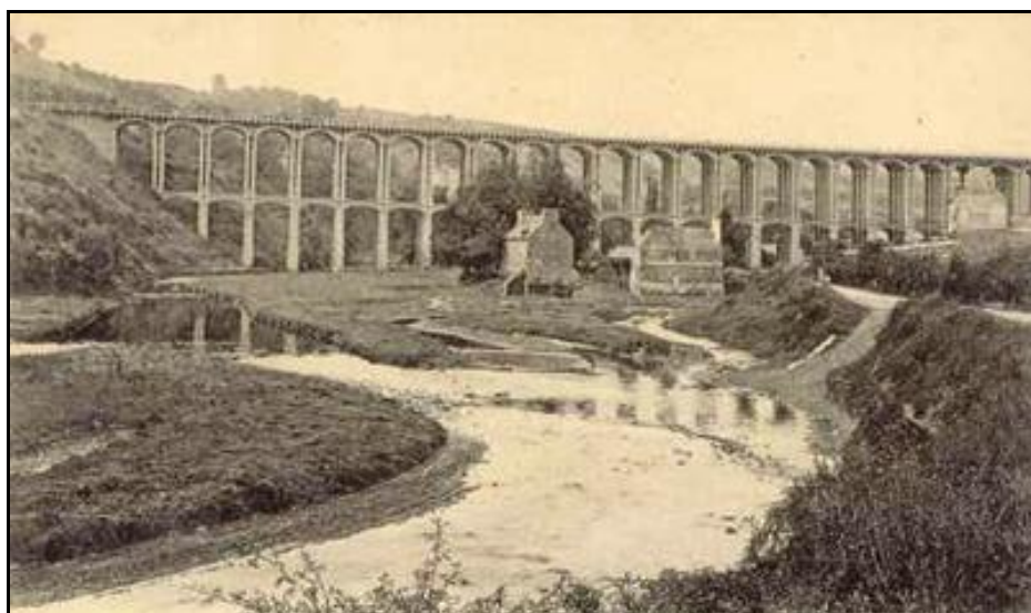
Ce viaduc mixte, rail route, réalisé entre 1903 et 1905 a été le plus spectaculaire des ouvrages construits par Harel de La Noë. D'une longueur de 259 m pour 33 m de haut, il avait la forme d'un Y.
