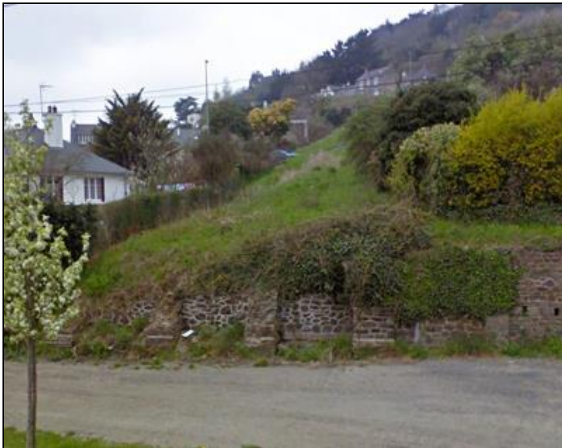
Dont il ne reste que cette trouée de verdure dans la pente et ces vestiges de maçonnerie au bord de la RD 24
