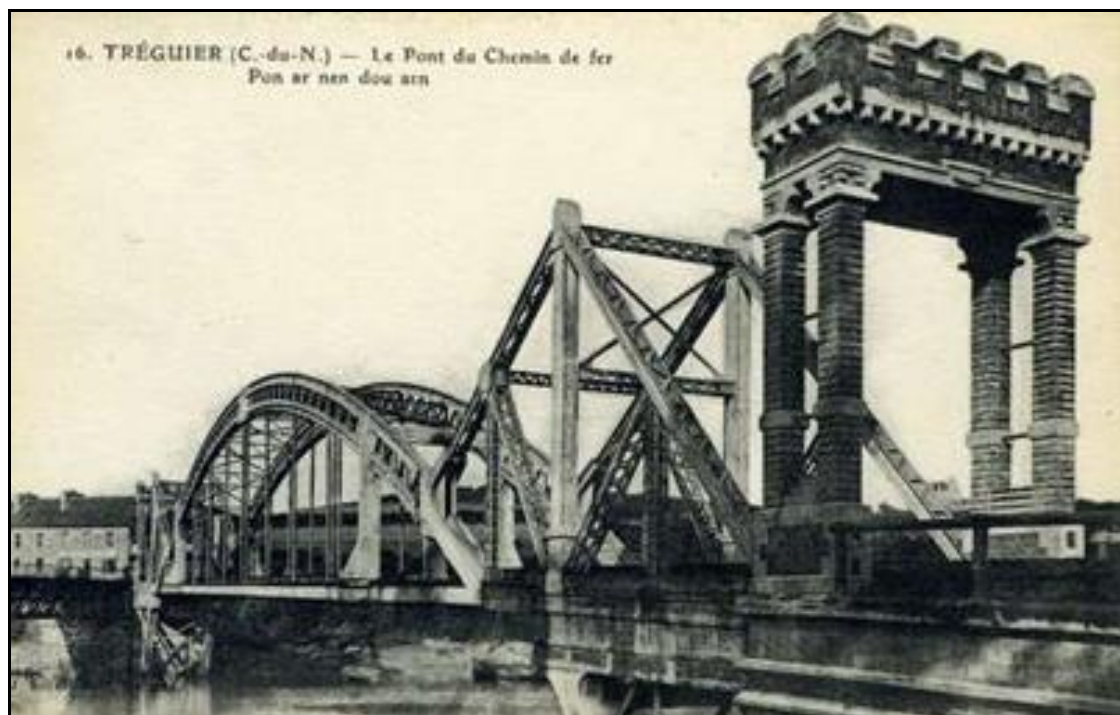
Gros plan sur l'architecture du Pont Noir ferroviaire qui montre bien les deux architectures triangulaires en porte-à-faux qui soutiennent le grand arc central
