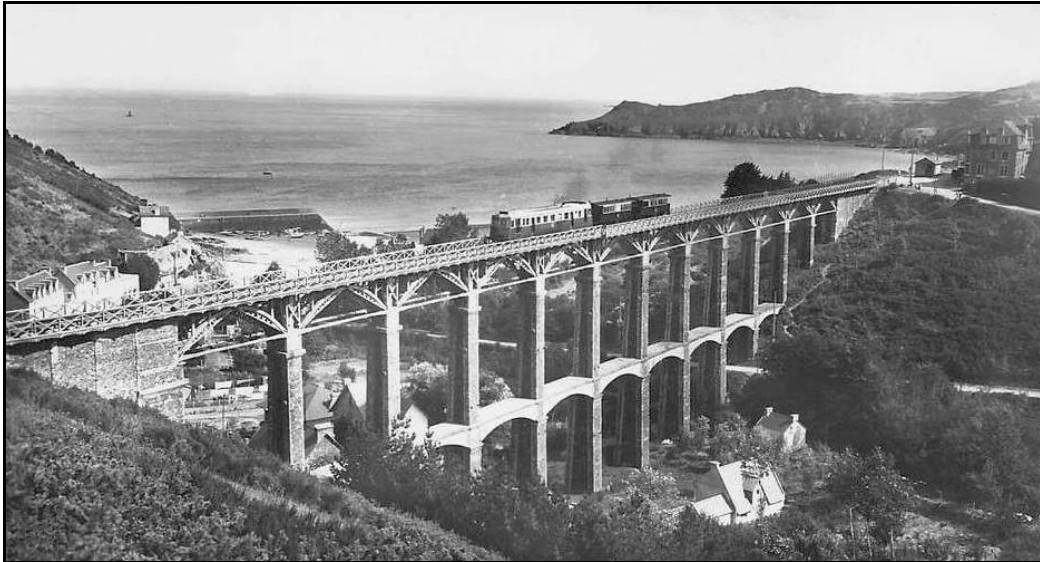
Deux autres vues du viaduc dans les derniers temps de la ligne La différence d'architecture de l'étage de renfort rajouté après coup est bien visible
